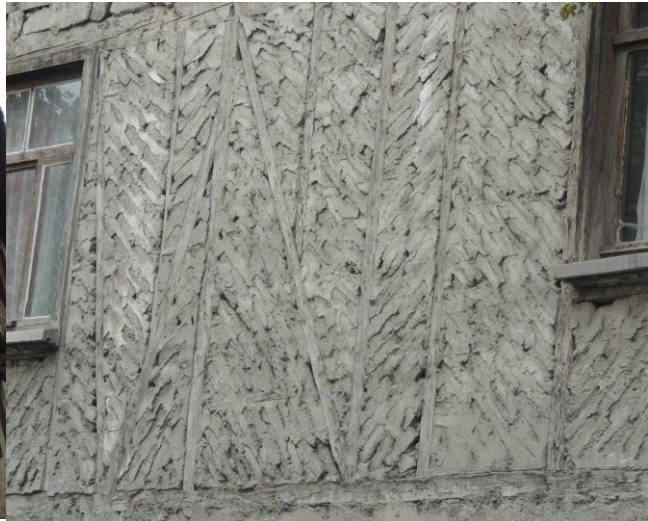
Şekil 8. Balıksırtı tuğla dolgulu duvar örneği, Safranbolu
