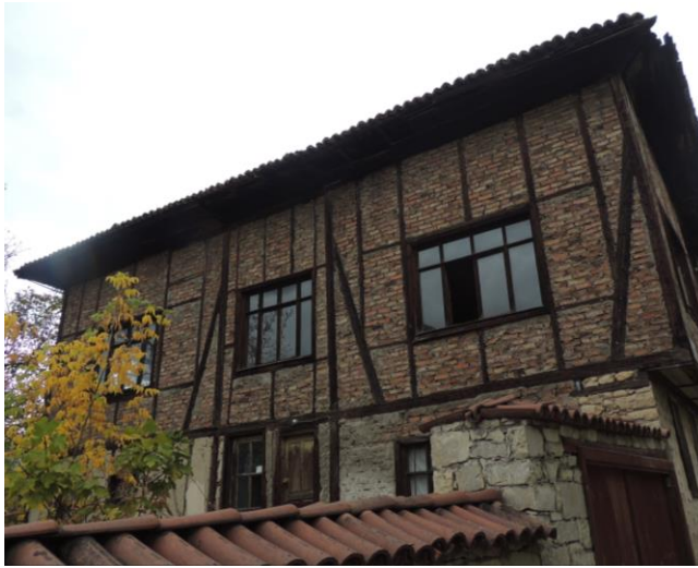
Şekil 7. Tuğla dolgulu hımiş duvar örneği, Safranbolu
