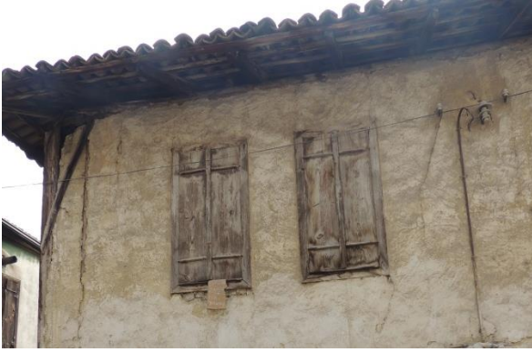
Şekil 5. Kireç harcı ile sıvanmış duvar
