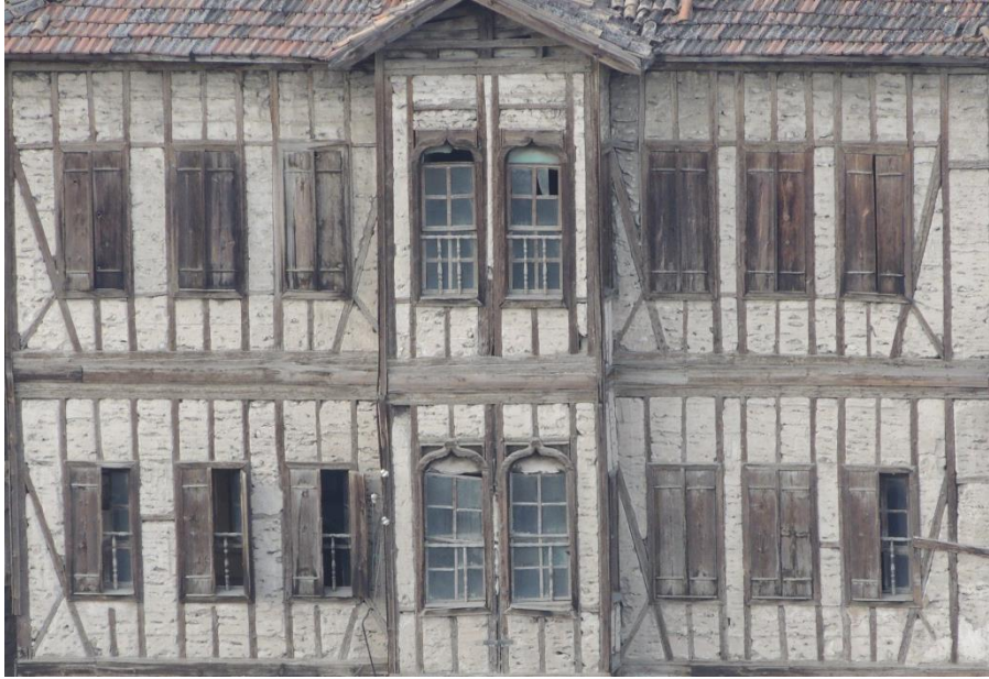
Şekil 4. Hımiş duvar örneği, Safranbolu
